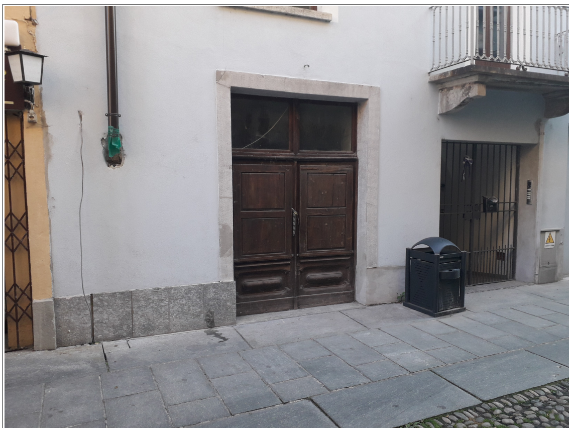
Foto n.4 – vista esterna locale ex negozio di Via Francesco Rolando 10
