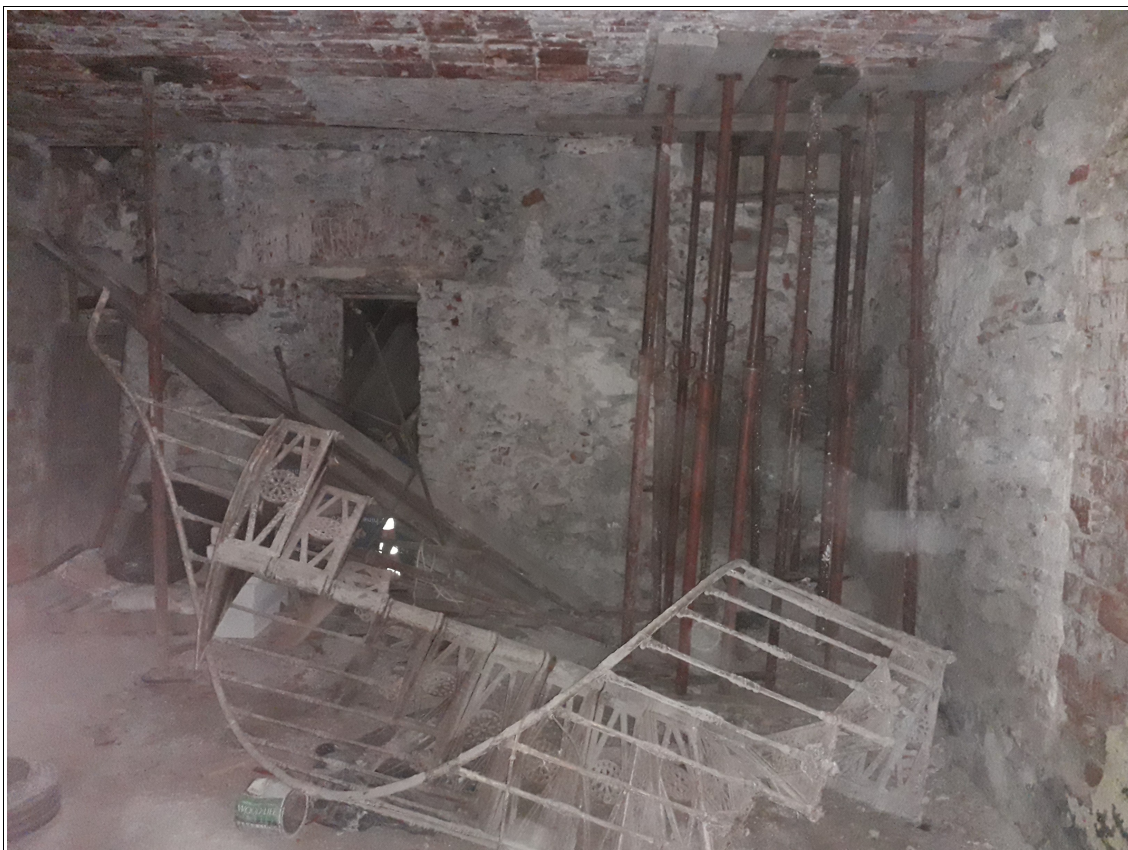
Foto n.2 – vista interna locale ex negozio di Via Francesco Rolando 6
