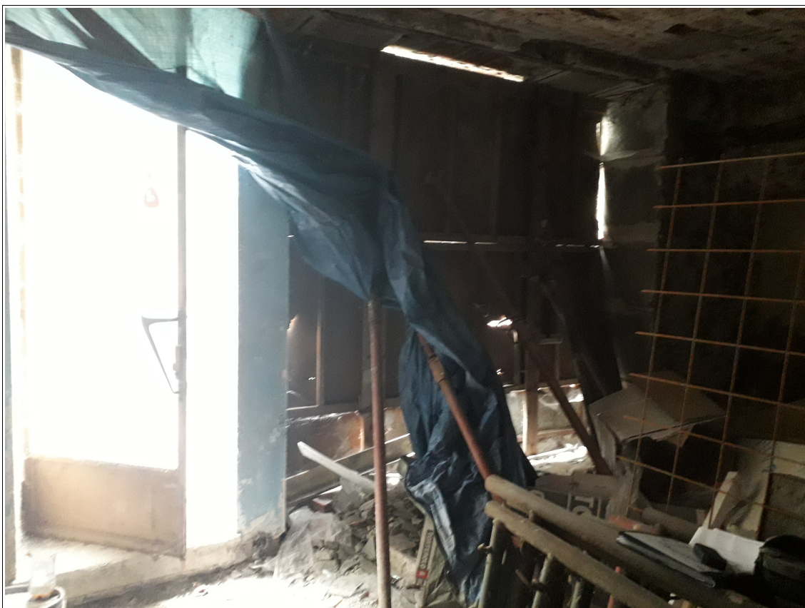
Foto n.3 – vista interna locale ex negozio di Via Francesco Rolando 6
