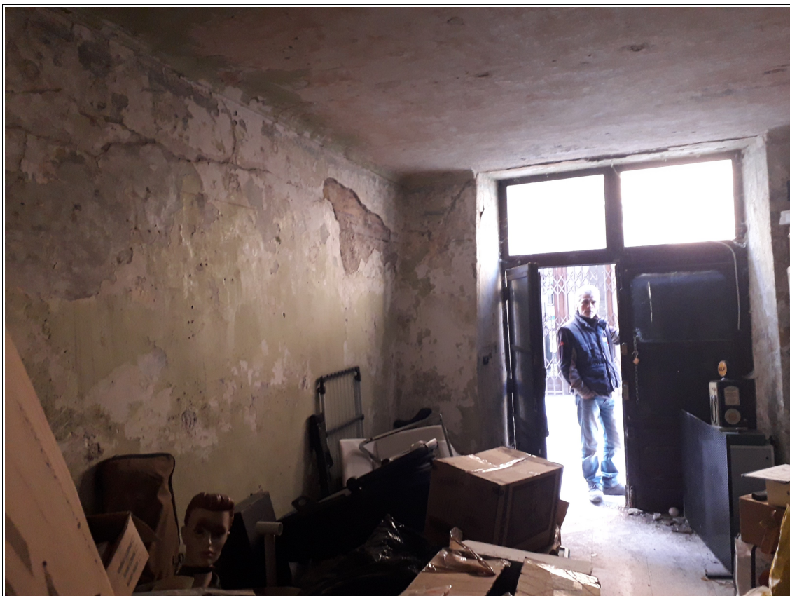
Foto n.6 – vista interna locale ex negozio di Via Francesco Rolando 10
