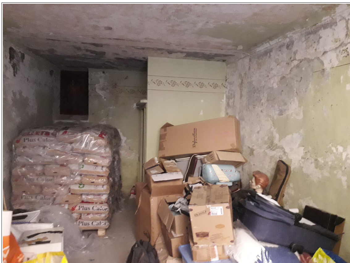
Foto n.5 – vista interna locale ex negozio di Via Francesco Rolando 10
