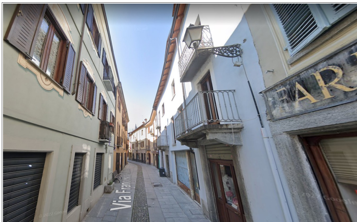
Foto n.8 – vista esterna del fabbricato nel contesto in cui è situato
