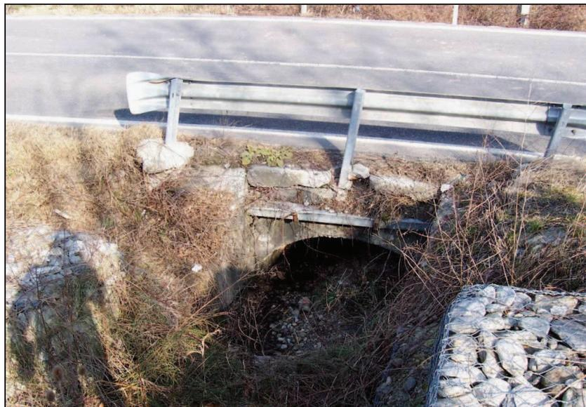
**Figura 1 – Attraversamento esistenti sul Rio Boarda: sezione insufficiente al deflusso di piena.**
