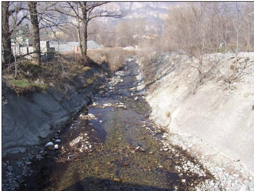
Figura 3 – Restringimento di sezione sul rio Gerardo presente a valle del ponte della ex S.S. 24.
