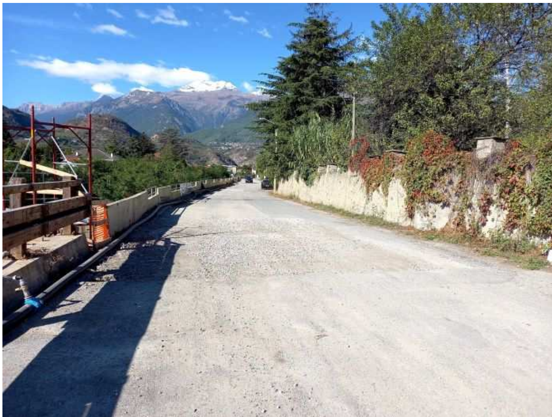
Foto 6: Via Montello sito scavo sondaggio
