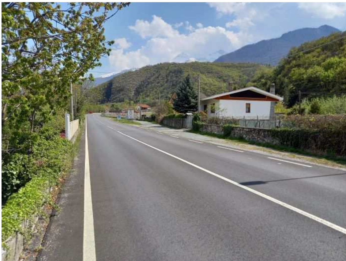
Foto 5: Tratto E2 – E3 su strada comunale asfaltata
