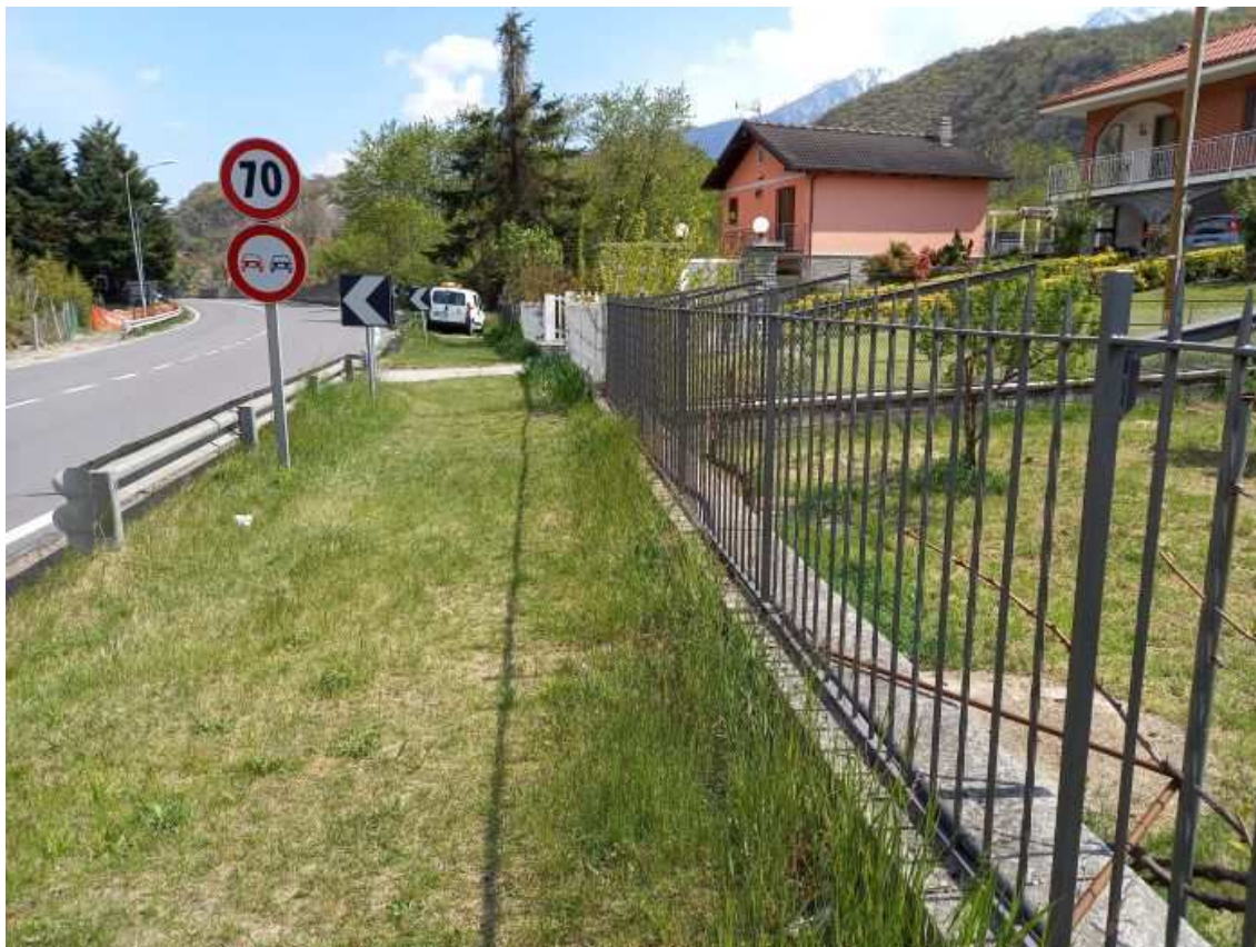
Foto 3: Tratto Z2-Z1 in banchina S.S. 24 (fossa biologica terminale da raccogliere sulla destra)
